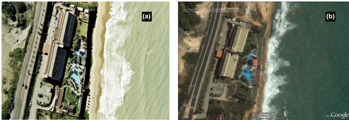
Figura 4 - Vista aérea do Hotel Pestana, em (a) fotografia datada de 2006 e, em (b) fotografia aérea datada de 2010. Fonte: SEMURB e Google Earth.
